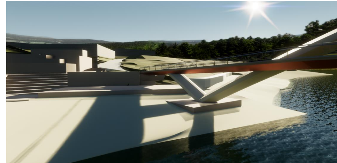
Imagen 10: Infografía en la que se pueden apreciar en un primer plano los puntales (Fuente: Propia)
