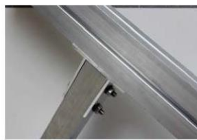
Unión pata-cordón superior
