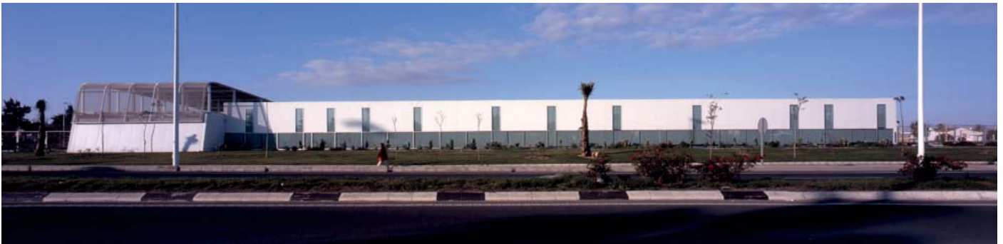
IMAGEN 2.12 Vista exterior, alzado del CDT, Torrevieja.
