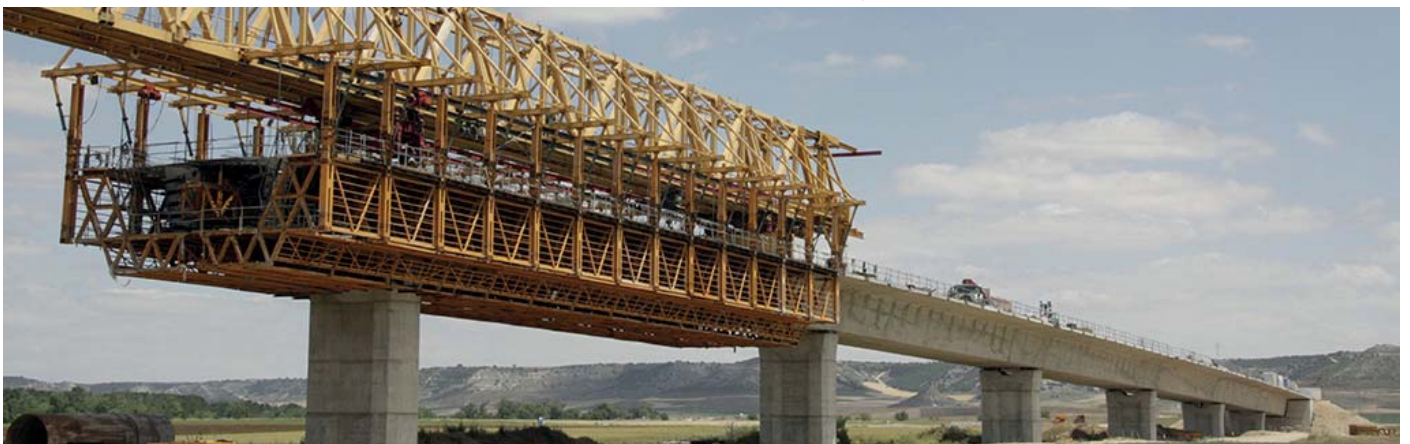
IMAGEN 3.29 Fotografía de la construcción de un puente mediante el postesado.
