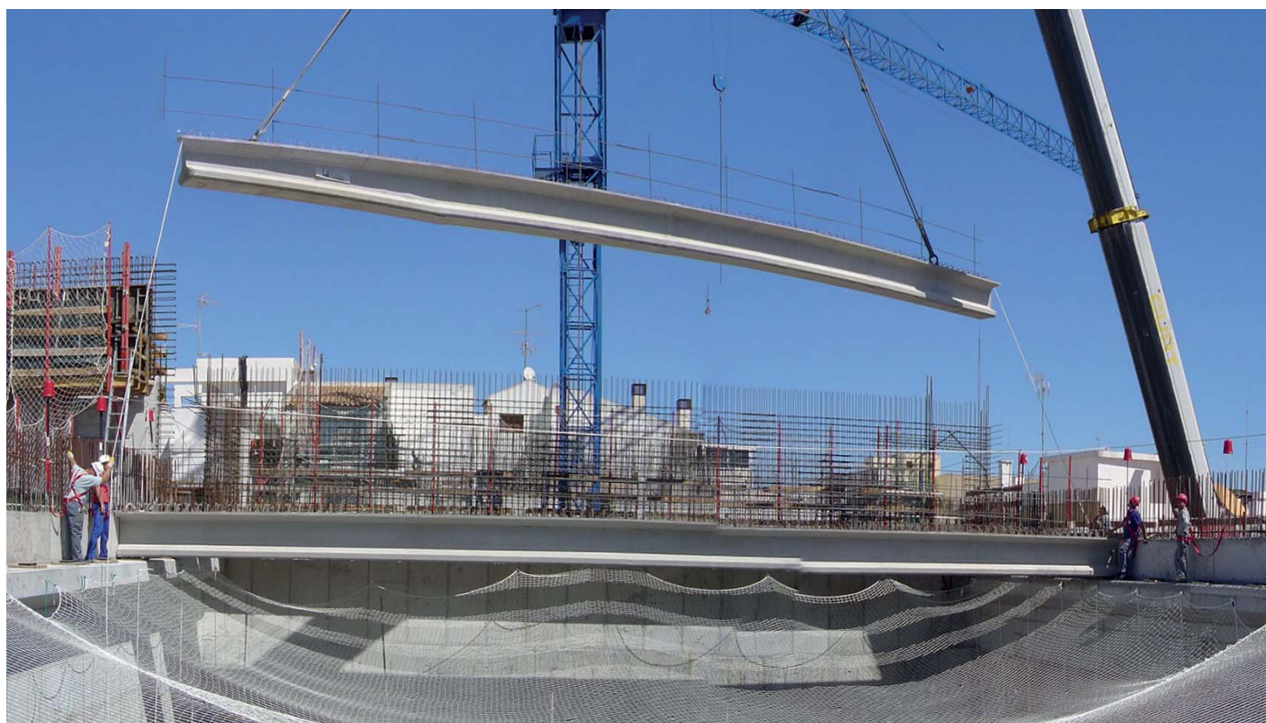
IMAGEN 3.17 Fotografía de la obra, colocación de las vigas sobre la ménsula creada en los muros P1 y P3.
