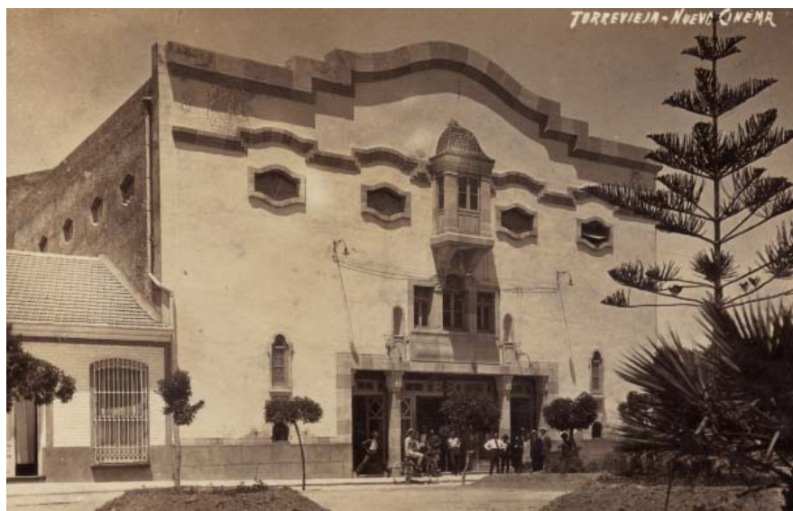
IMAGEN 1.1 Fachada del teatro Nuevo Cinema al poco tiempo de su construcción.
