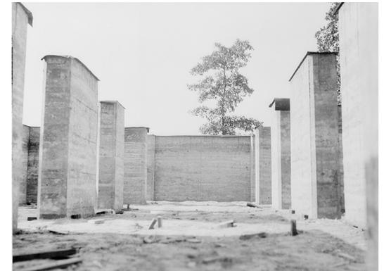
Figura 36. Muros completados de las viviendas.
