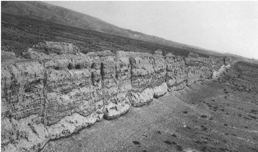
Figura 29. Muro de tapia de la Antigüedad.
