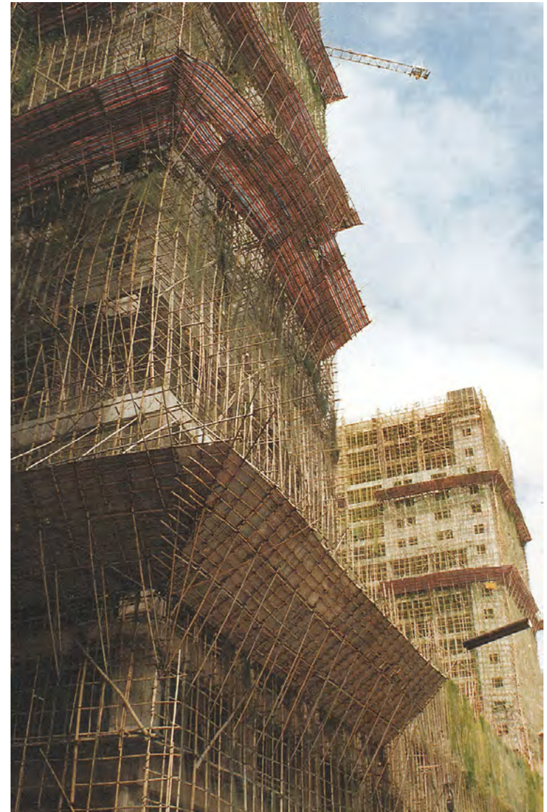
Andamios de bambú en la construcción de edificios de gran altura Fuente: paradisebackyard.blogspot.com
