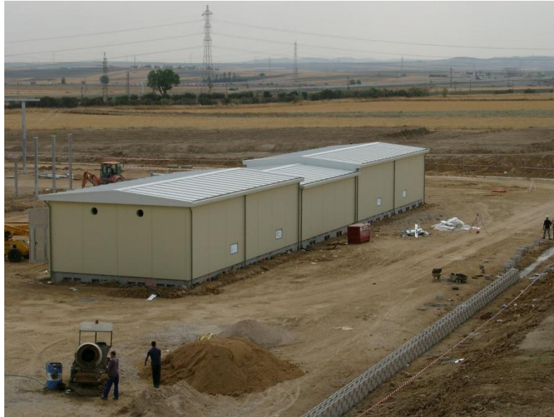
Figura 18: Edificio para las instalaciones eléctricas de la instalación.
