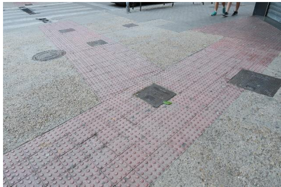
Fotografía 14 Pavimento para personas con visibilidad reducida erróneamente dispuesto
