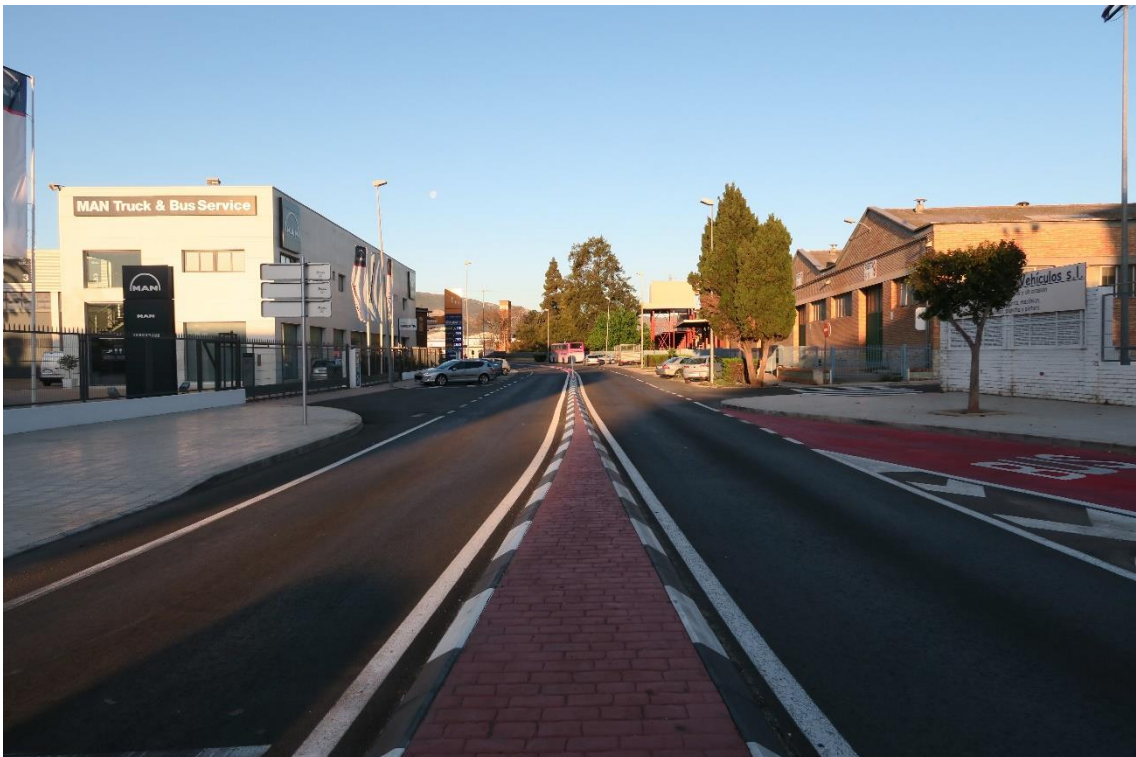
Fotografía 27 Isla deflectora de la glorieta del P.K. 2+733
