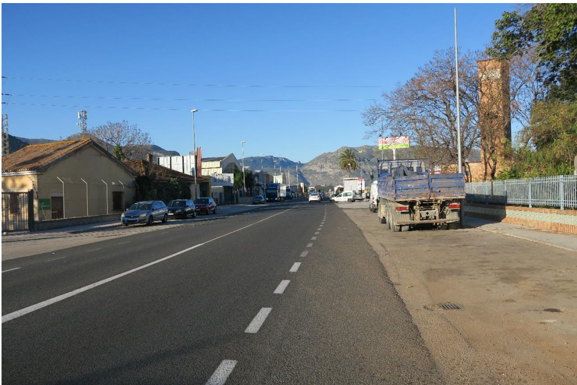
Fotografía 7 Sección de la carretera a la altura del polígono industrial
