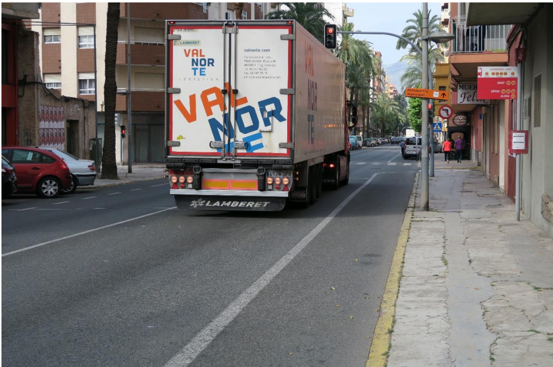
Fotografía 5 Arcén de tamaño excesivo presente en la travesía.
