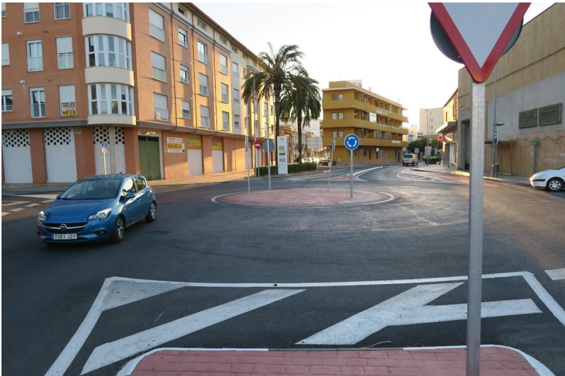
Fotografía 25 Glorieta situada en el P.K. 2+733, a la entrada del polígono industrial
