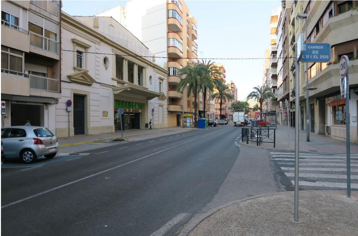
Fotografía 21 Falta de paso de peatones en zona de gran afluencia de peatones
