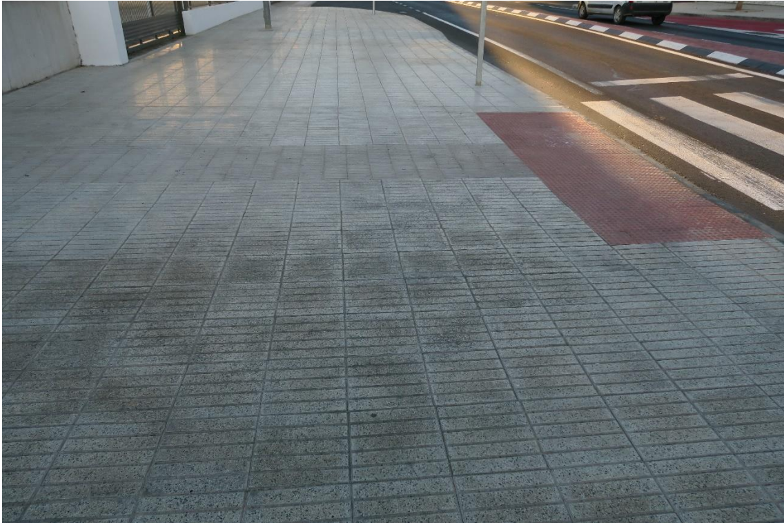
Fotografía 28 Disposición del pavimento en el cruce del polígono industrial
