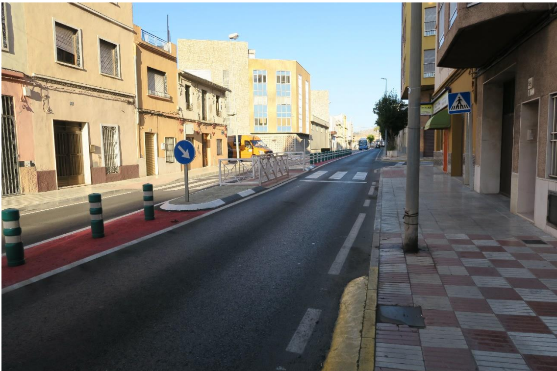
Fotografía 23 Nueva mediana situada alrededor del P.K. 2+550, antes del polígono industrial (1/2 fotos)
