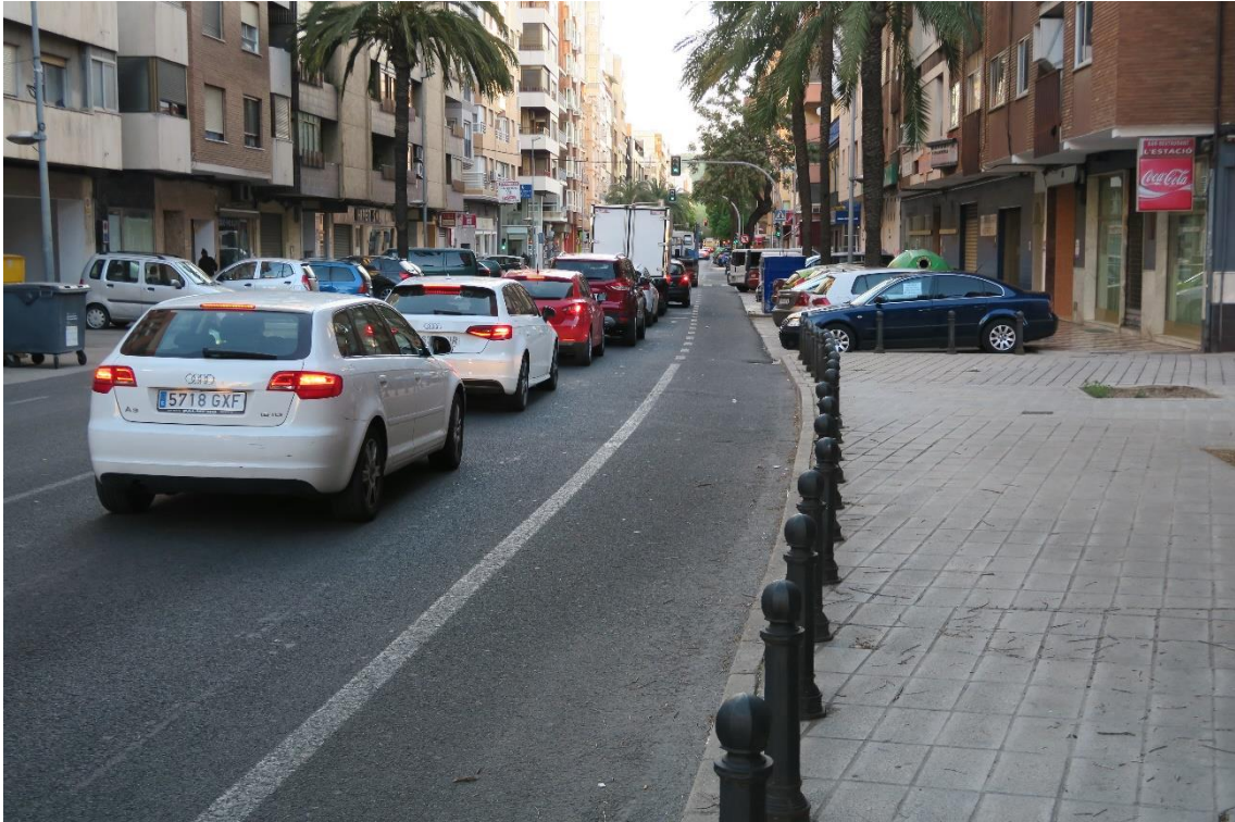
Fotografía 6 Tamaño del arcén en un tramo de la travesía
