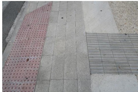
Fotografía 15 Disposición errónea de los elementos de accesibilidad para personas con discapacidad física y visibilidad reducida.
