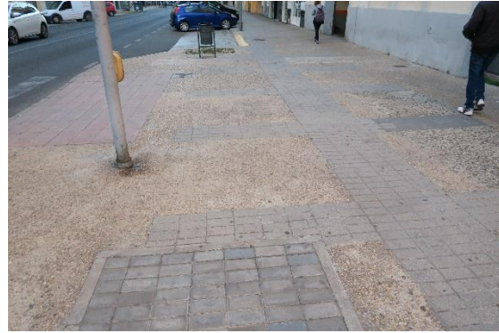
Fotografía 13 Incoherencia en el uso del pavimento empleado en la travesía. Ejemplo 2
