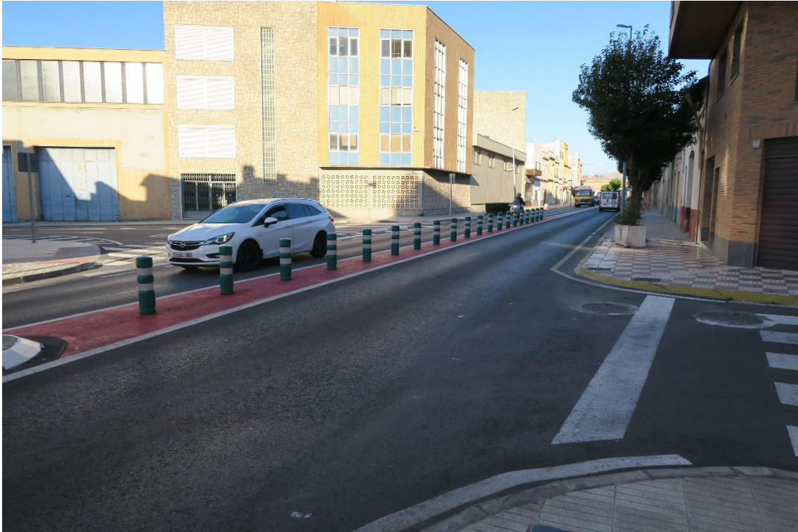
Fotografía 24 Nueva mediana situada alrededor del P.K. 2+550, antes del polígono industrial (2/2 fotos)
