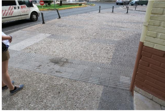
Fotografía 12 Incoherencia en el uso de pavimentos empleado en la travesía. Ejemplo 1
