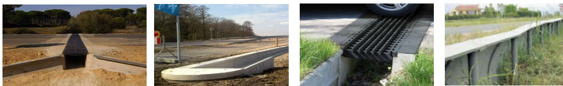
Figuras 11-14. De izquierda a derecha: paso de fauna para anfibios con la estructura de guía en embudo, curva de la estructura guía, rejilla de detección y perfil de la estructura guía prefabricada de fácil colocación. Fuentes: GIASA, COST 341 y www.maibach.com (marzo 2018)
