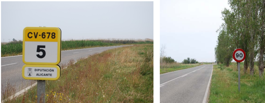
Figuras 27 y 28. Señalización kilométrica de la carretera CV-678 y limitación establecida por la DGT (carretera regional de dos carriles y sin arcén).
