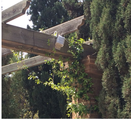
Figura 3.1. Detalle de la zona 1.1 y situación del sensor instalado en esta zona.
