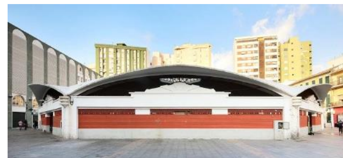
Imagen 18 Bóvedas en voladizo (Instituto Andaluz, 2001)
