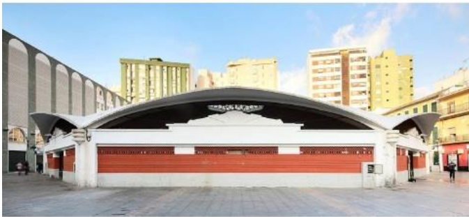
Imagen 25 Bóvedas en voladizo (Instituto Andaluz, 2001)
