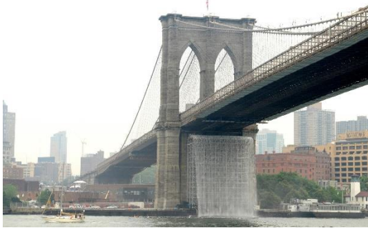
Ilustración 41 The New York city Waterfalls. Instalación de Olafur Eliasson en 2008, en el puente de Brooklyn.
