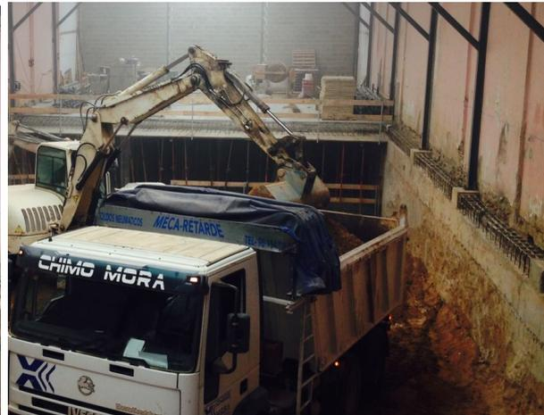
*Ilustración 41 Vaciado siguiente tramo concluida la estructura*
