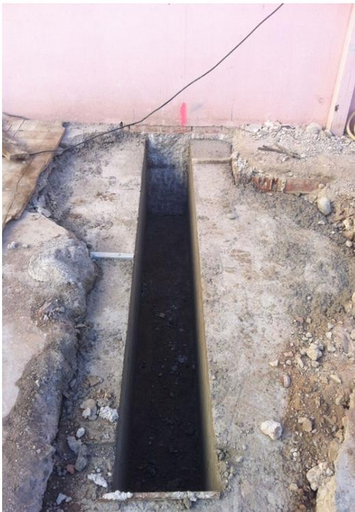
*Ilustración 5 Mortero en fondo y murete guía*
