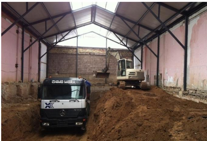
*Ilustración 40 Primer vaciado a -1,50 metros*
