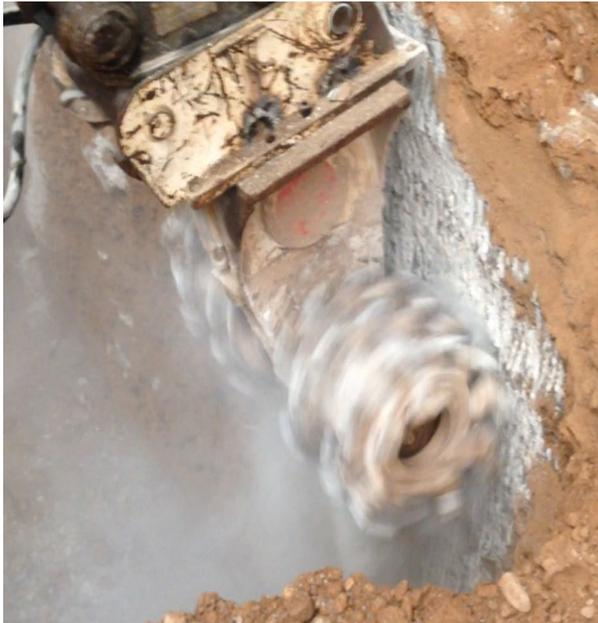
*Ilustración 51 Fresado acabado grueso*
