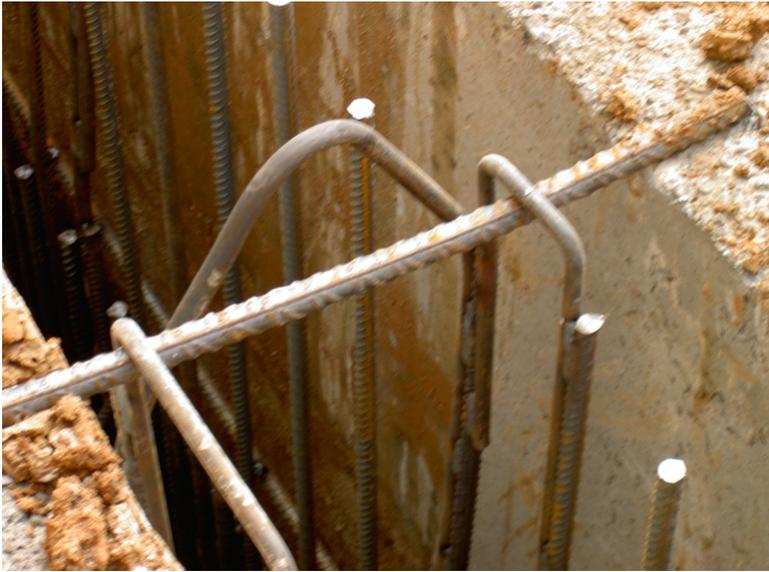
Ilustración 28 Apoyo de la jaula en muretes guía
