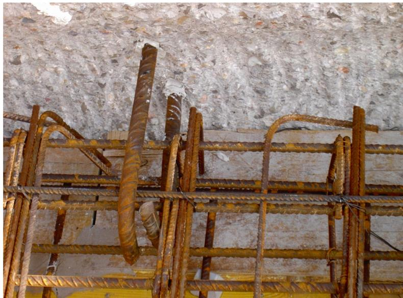
*Ilustración 64 Conectores con losa de sótano*
