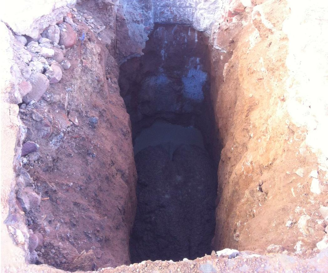
*Ilustración 4 Excavación de las capas inestables*
