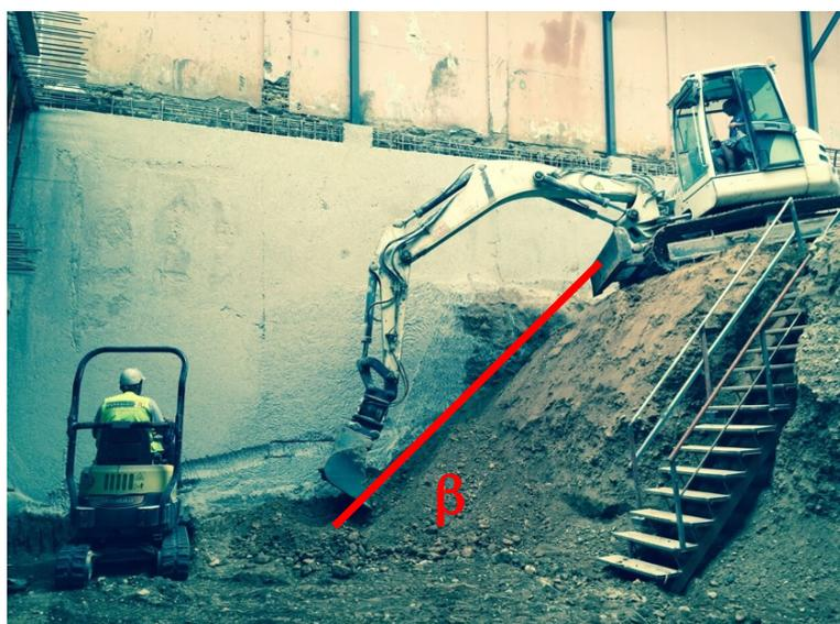
*Ilustración 49 Excavación con talud hasta cota de excavación*
