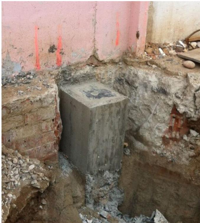
*Ilustración 6 Pilar hormigonado*
