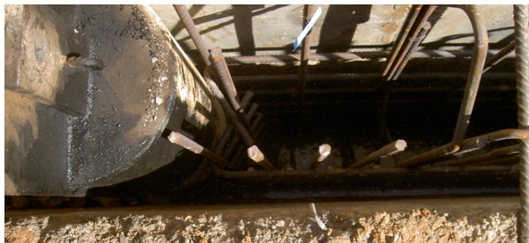
*Ilustración 23 Colocación de la junta*
