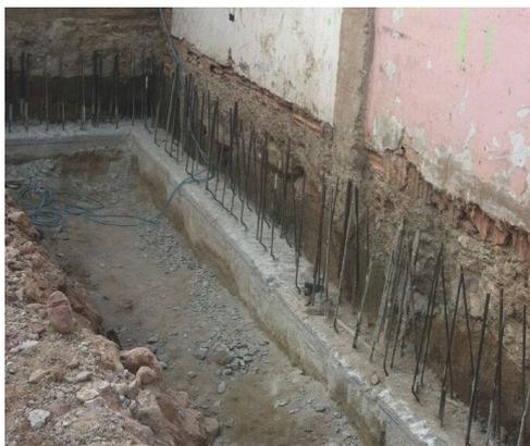
*Ilustración 35 Descabezado del muro pantalla*
