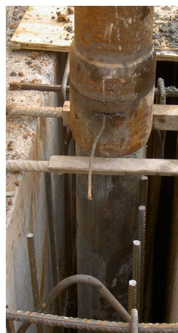
Ilustración 32 Ensamblaje Tubo Tremie
