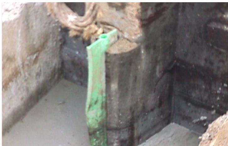
Ilustración 25 Junta trapezoidal con junta wáter-stop <https://enriquealario.com/ejecucion-muros-pantalla-paso-a-paso/>
