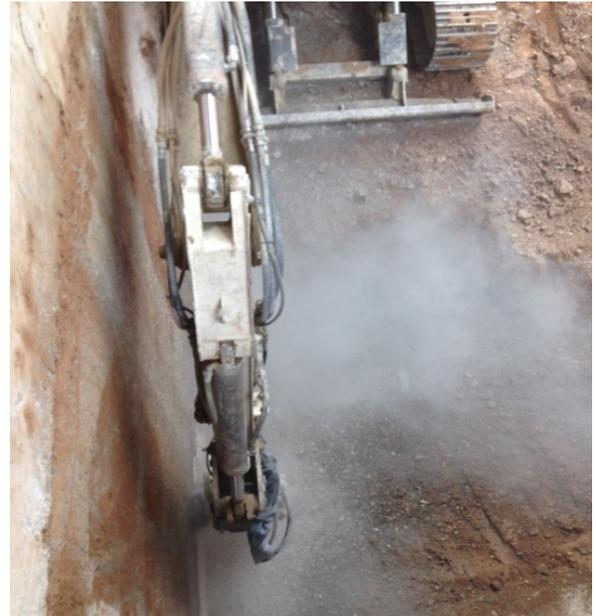
*Ilustración 52 Fresado acabado fino*
