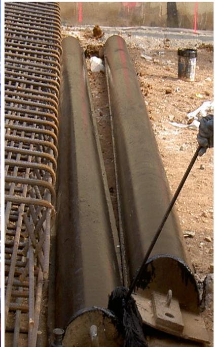
*Ilustración 22 Impregnación desencofrante*
