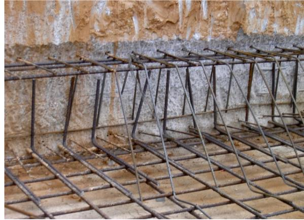
*Ilustración 63 Enlace de esperas con armado de la losa*
