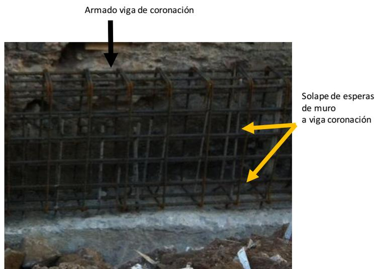
Ilustración 37 Junta de hormigonado en viga de coronación
