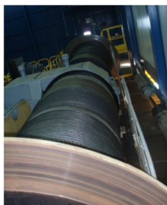
Ilustración 8. Tambores del sistema de elevación de pluma
