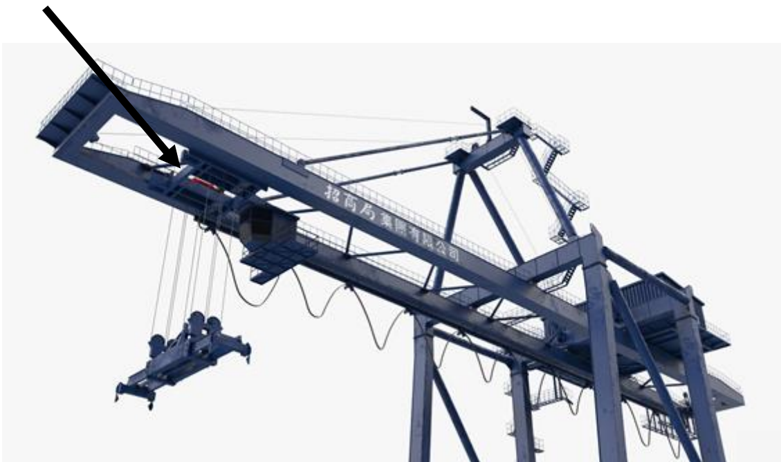
Ilustración 10. Vista de la grúa desde la zona inferior
