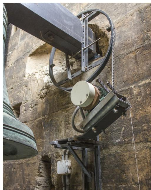
Fig.48: Motor de una campana electrificada.
