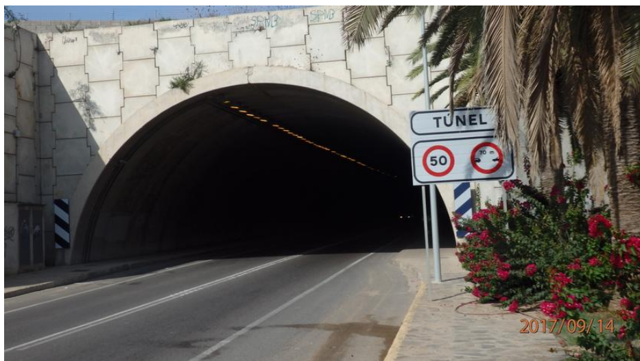
Figura 32: Foto de túnel
