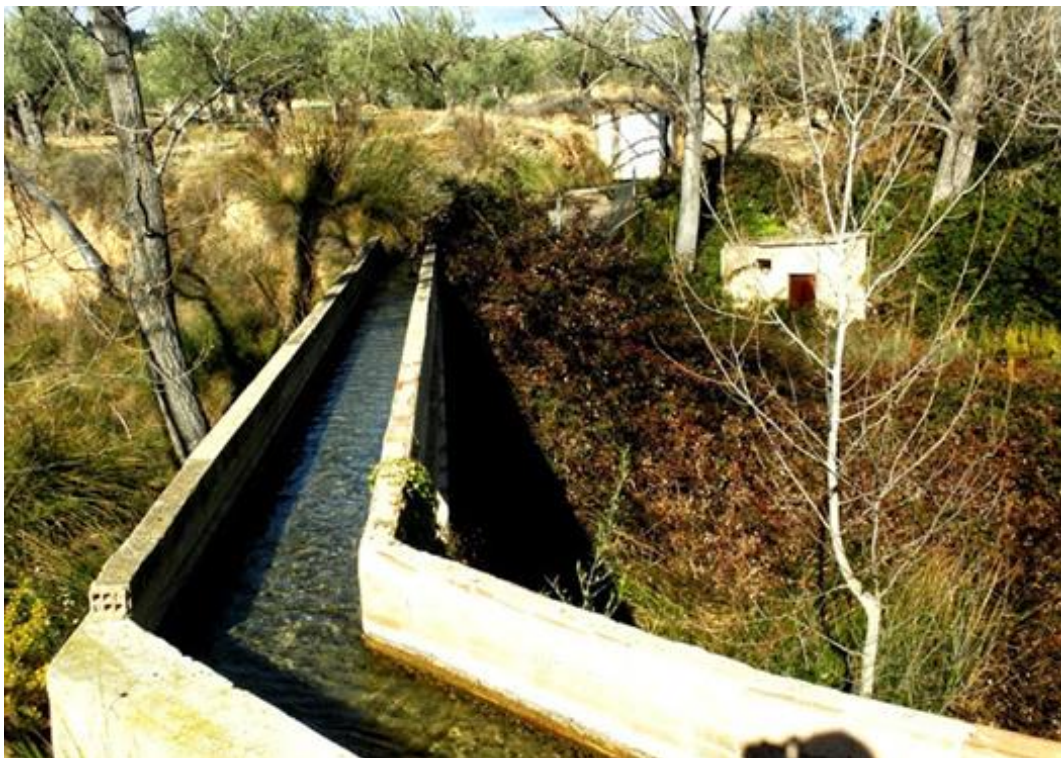
Ilustración 15: Acequias de canalización de la huerta de Ayora
