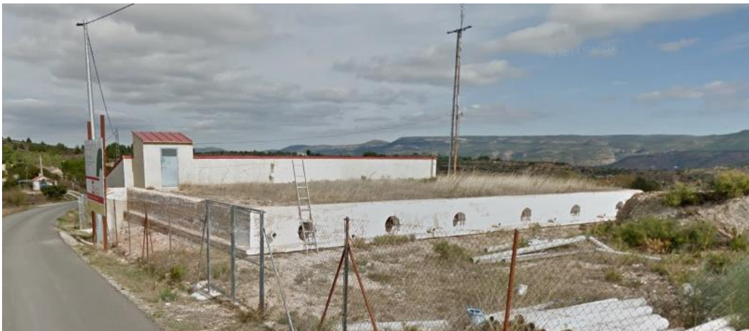
Ilustración 4: Foto exterior del depósito (Google Maps)
