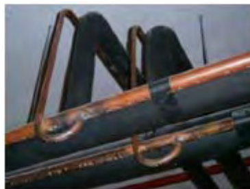
Ilustración 38 - Detalle derivación línea de líquido parte inferior de tubería.
