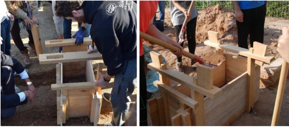
Figura 2. Taller de construcción con tapia. Fuente: autores.
