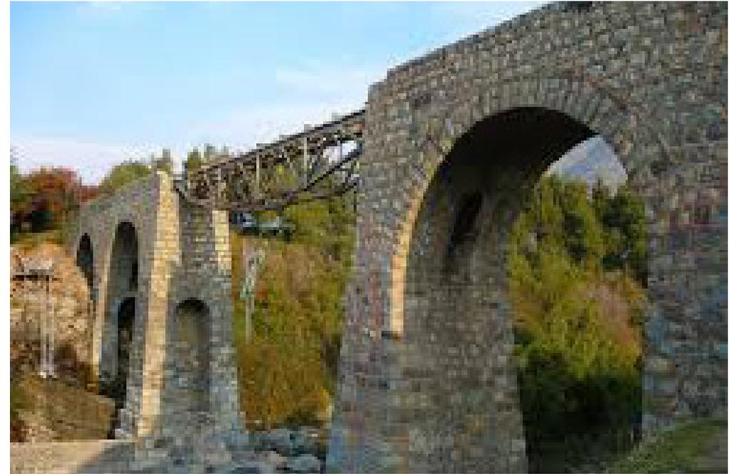
Imagen: Puente con estructura mixta.
