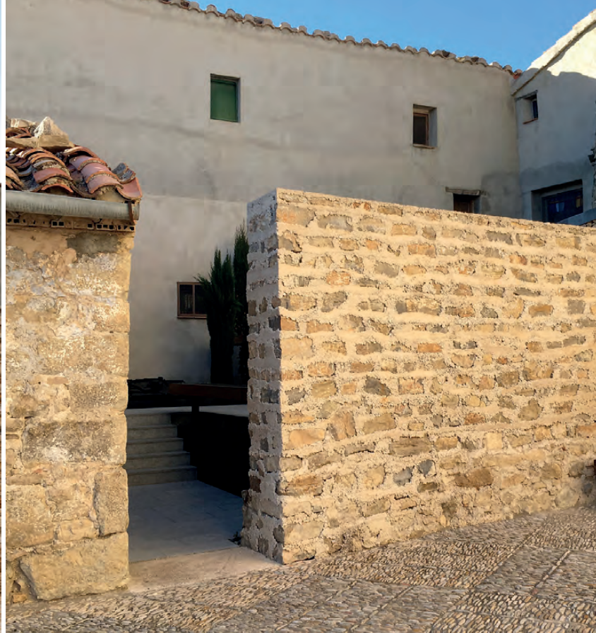
Figura 9. Muro de cierre de recinto del nuevo acceso (2017) / Figure 9. Closing wall of the new entrance (2017).
