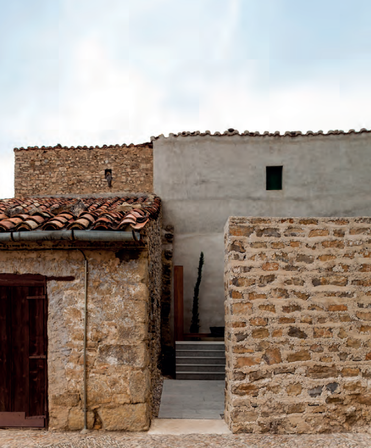
Figura 8. Entrada a recinto del nuevo acceso (2014). ©Milena Villalba fotografía de arquitectura / Figure 8. Entrance to the new enclosure (2014). ©Milena Villalba photographer.
