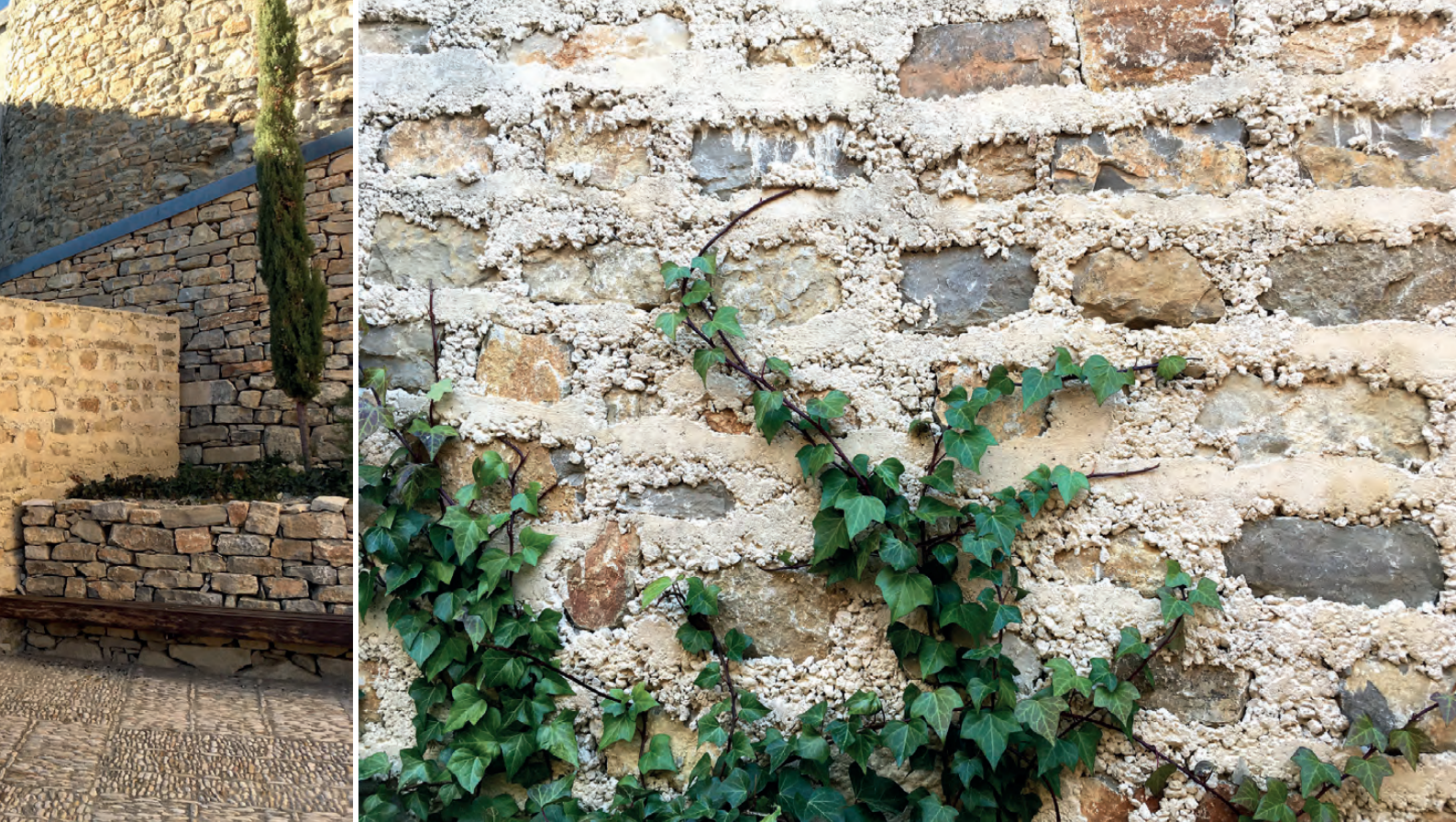
Figura 10. Detalle del muro del recinto del nuevo acceso (2017) / Figure 10. Detail of the wall (2017).
