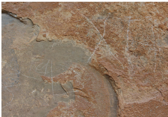
Figura 12. Disjunció de la superfície en forma de descamació (Barreda, 2012).
