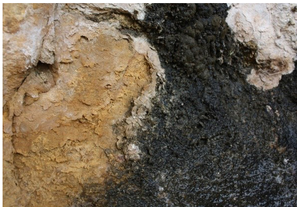
Figura 24. Exfoliació i arenització del material petri (Barreda, 2012).
