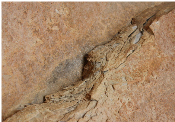
Figura 11. Ruptura de la superfície pètria en forma d'esquerdes (Barreda, 2012).
