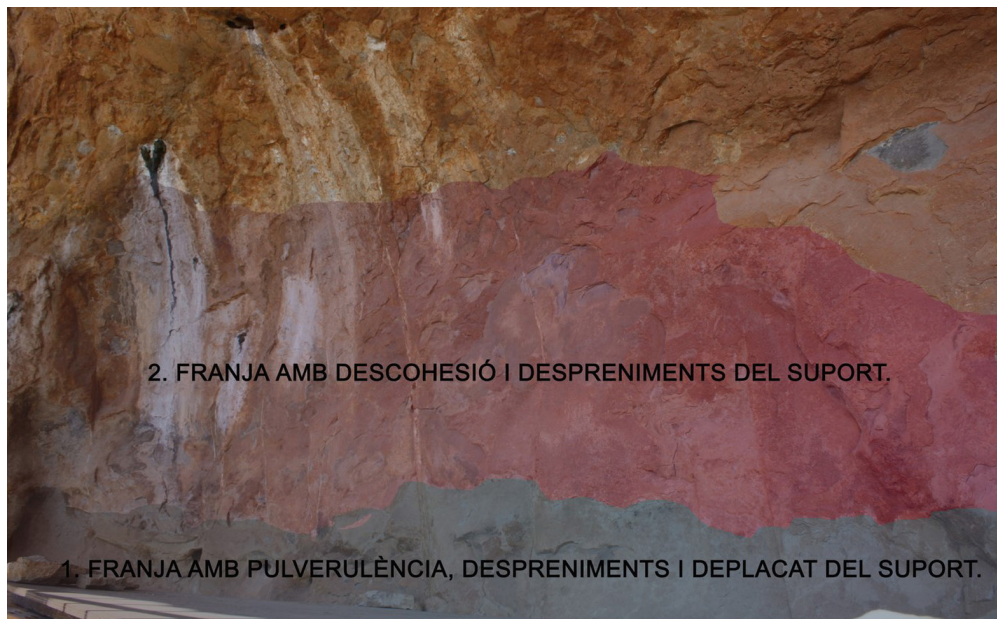
Figura 8. Alteracions físicomecàniques del suport petri de l'Abric de Pinos. Vista general de l'abric on s'observa com les parts inferiors que pateixen major insolació i canvis bruscs de temperatura, presenten en conseqüència major deterioració, descamació, pèrdues de suport rocós, i més pulverulència. També es detecten vessaments actius de carbonat càlcic, deguts a la circulació continuada d'aigua amb creixement biològic (Barreda, 2012).
