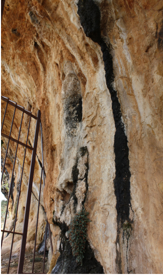
Figura 17. Formació de concrecions calcàries a causa de l'activitat dels vessaments continuats per la filtració d'aigua (Barreda, 2012).
