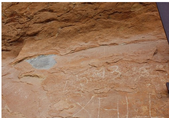
Figura 15. Dipòsit de pols superficial, sobre la pàtina de color ataronjat generada per oxalats càlcics (Barreda, 2012)
