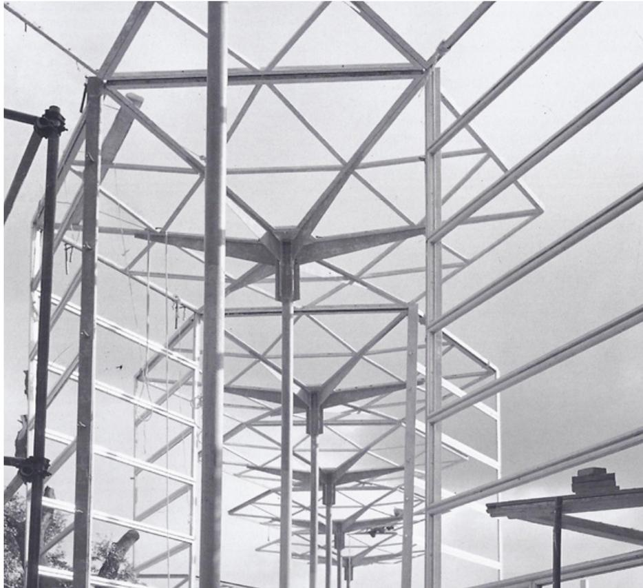
Fig.20. Imagen de los soportes y carpinterías del pabellón de Bruselas durante su construcción, 1958.
