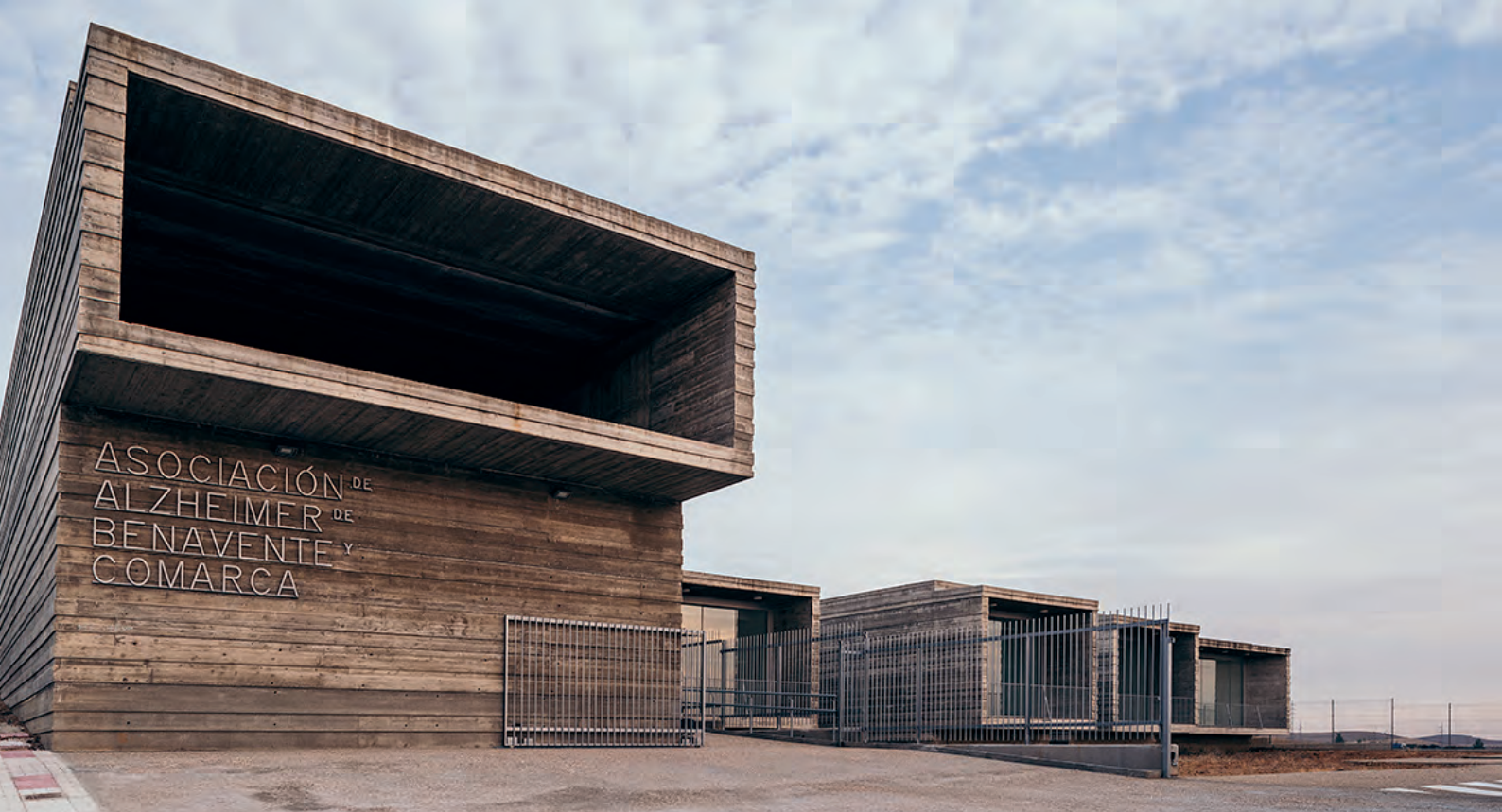
Figura. 2 Imagen exterior del acceso al edificio. ©Javier Bravo / Figure 2. Exterior view of the building access. ©Javier Bravo.
