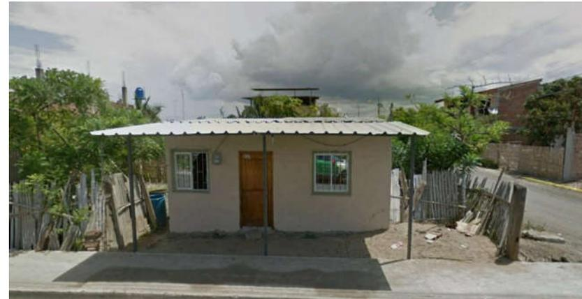
Imagen 23: Vivienda con mampostería de ladrillo y cubierta de zinc
