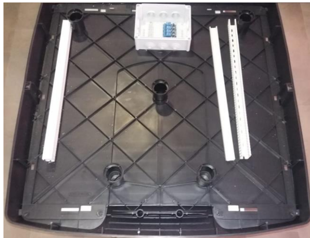
Figura 5.36 Caja hermética y canaletas atornilladas en la base de la caseta
