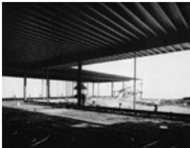
En cuanto a la estructura, se adopta una trama cuadrada de 6 metros, duplicando la extensión respecto a las anteriores viviendas del arquitecto. Se utilizan vigas de sección en I de 300 mm y pilares de sección en H de 100 mm. A diferencia de la casa Bailey, en esta vivienda las vigas sobresalen de la línea de pilares para sostener los grandes vuelos de la cubierta que otorgan de una gran sensación de ligereza al proyecto.<sup>22</sup>
