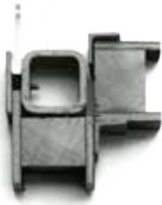
En cuanto a la estructura, Ellwood empleó pilares de tubo de acero cuadrado de 50 milímetros y vigas de tubo rectangular de 50 x 140 milímetros, y con un único detalle de nudo resolvió las uniones de toda la estructura.
