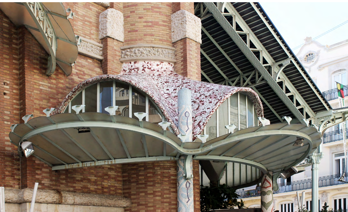
IMAGEN 40. Detalle de la pequeña cubierta que nace del gran soporte de la fachada de Conde Salviatierra (Imagen propia)
