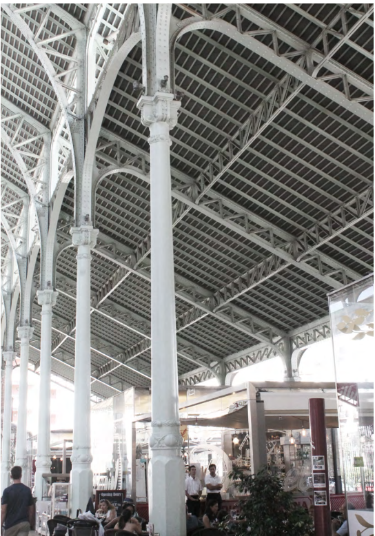
IMAGEN 54. Detalle de los pilares (Imagen propia)
