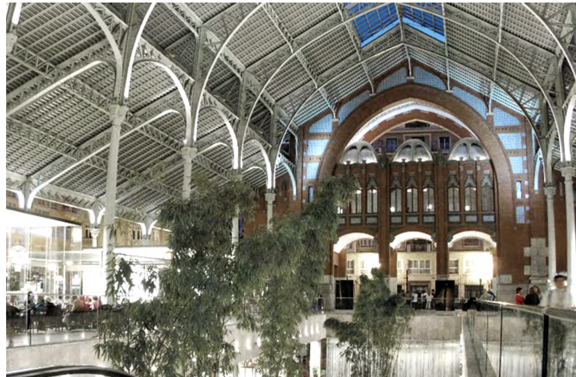
IMAGEN 35. Fotografía del interior del Mercado de Colón iluminado por la noche (Imagen propia)
