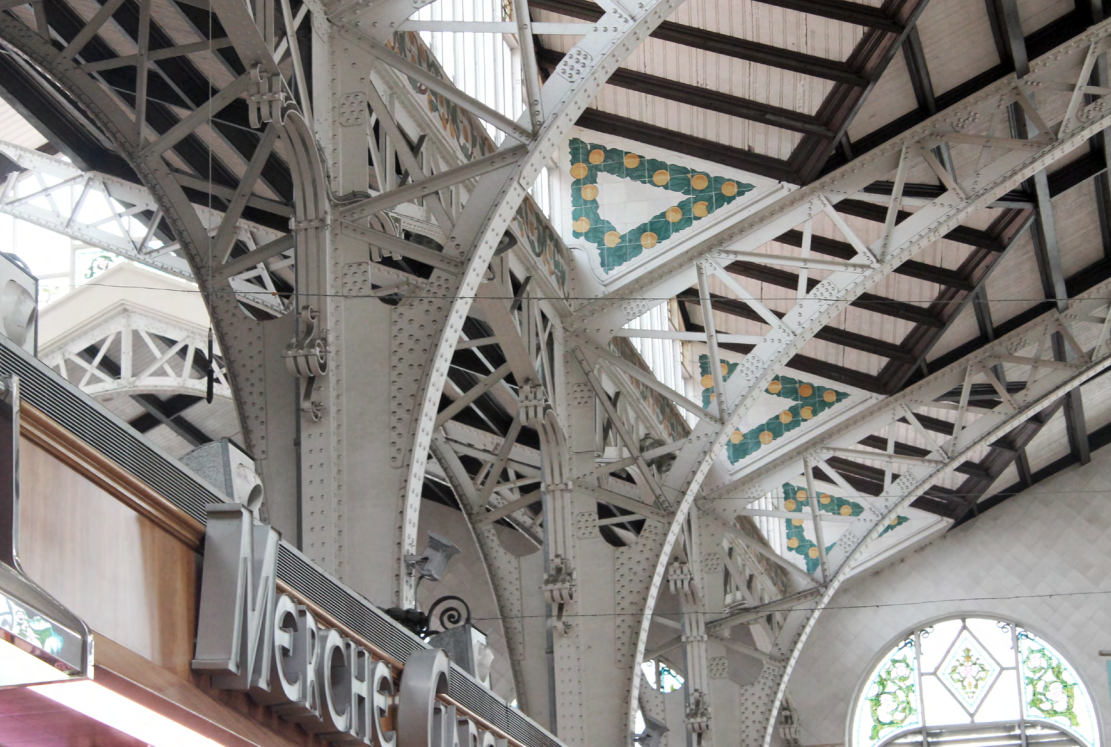
IMAGEN 101. Fotografía de la cubierta: detalle de coronación de pilares (Imagen propia)
