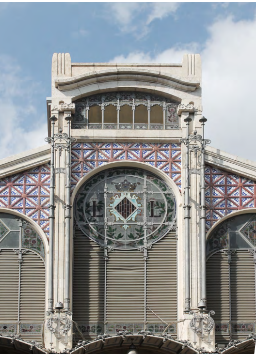
IMAGEN 89. Remate arco central de la fachada principal (Imagen propia)
