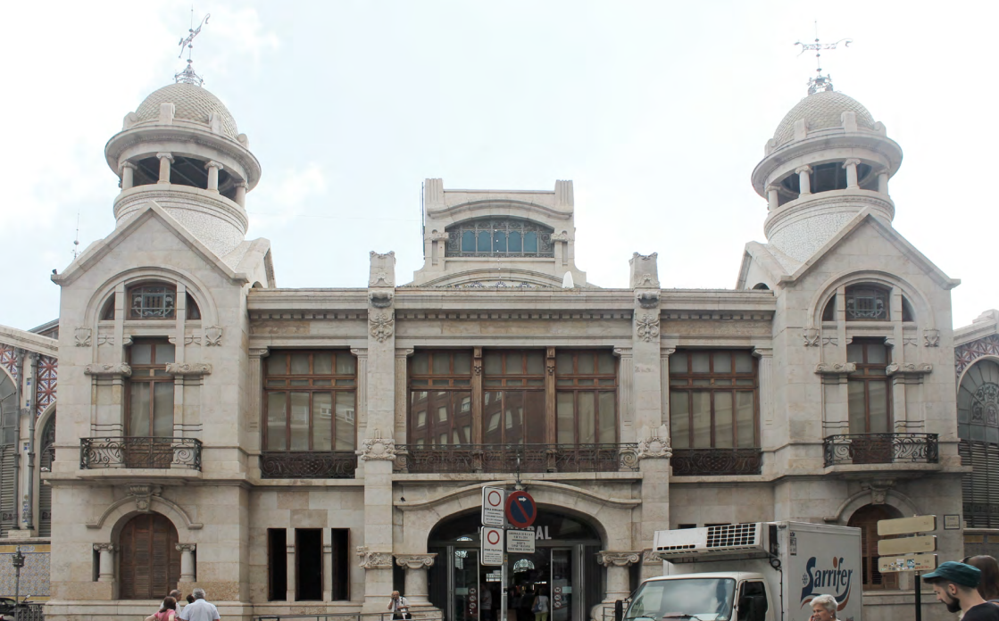
IMAGEN 91. Fachada esquina entre Avenida Barón de Cárcer y Calle Calabazas (Imagen propia)
