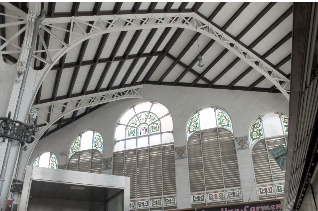
IMAGEN 102. Fotografía de la cubierta: detalle de cerchas (Imagen propia)
