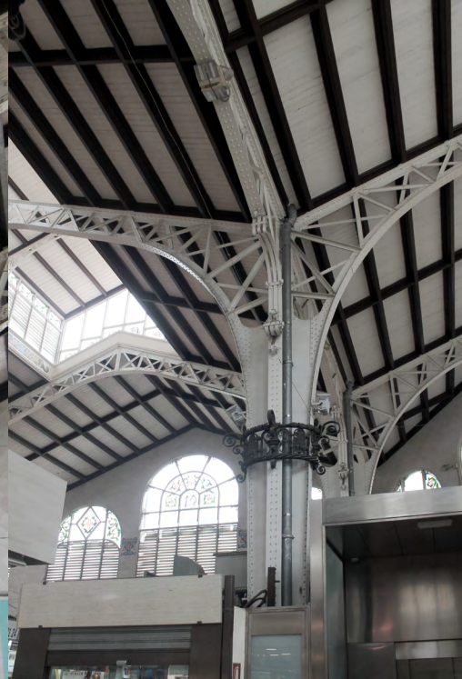
IMAGEN 103. Fotografía del detalle del pilar (Imagen propia)
