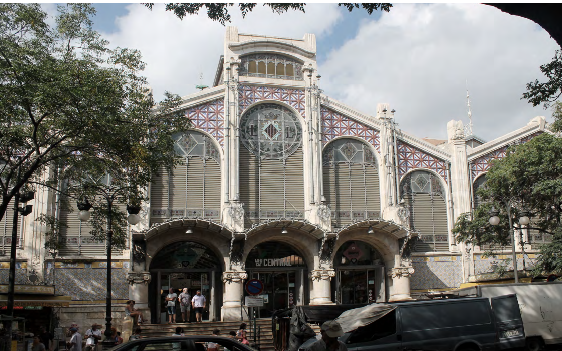
IMAGEN 69. Fotografía actual del Mercado Central (Imagen propia)
