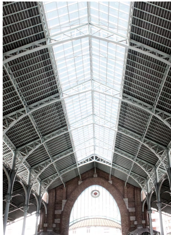
IMAGEN 55. Detalle de la cubierta (Imagen propia)
