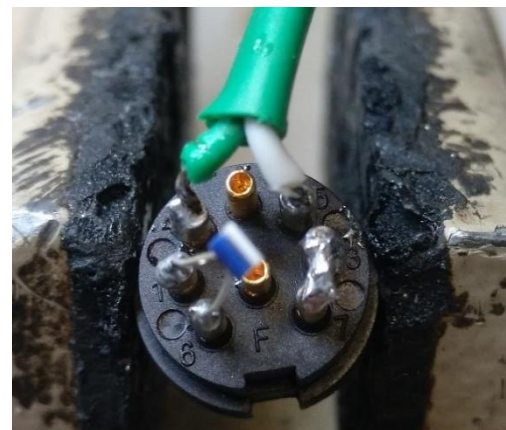
Figura 32. Conexiones termopar al conector de 8 pines.
