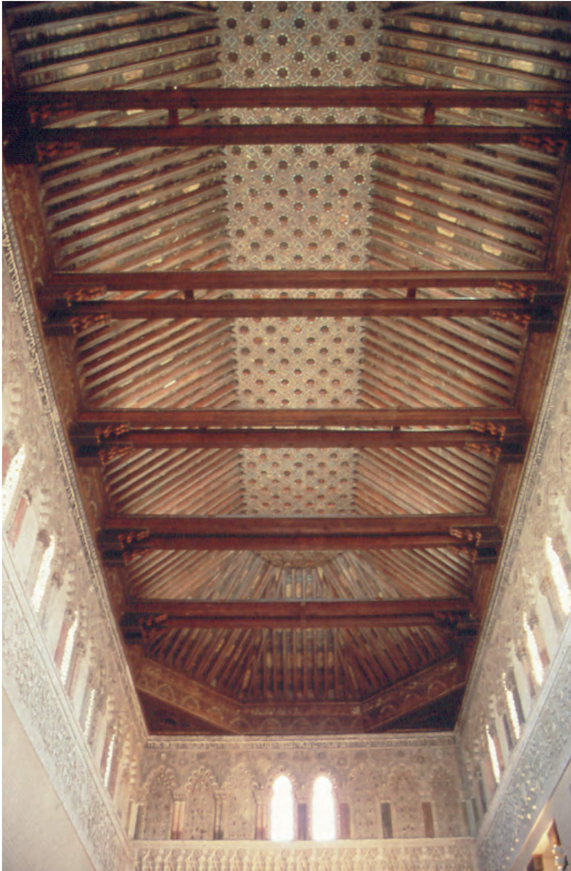
30. El artesonado se limpia y se unifica la coloración
