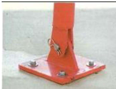
Fig. 45 Unión articulada con placa de anclaje [24].
