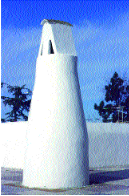
10. Chimenea típica de ventilación
