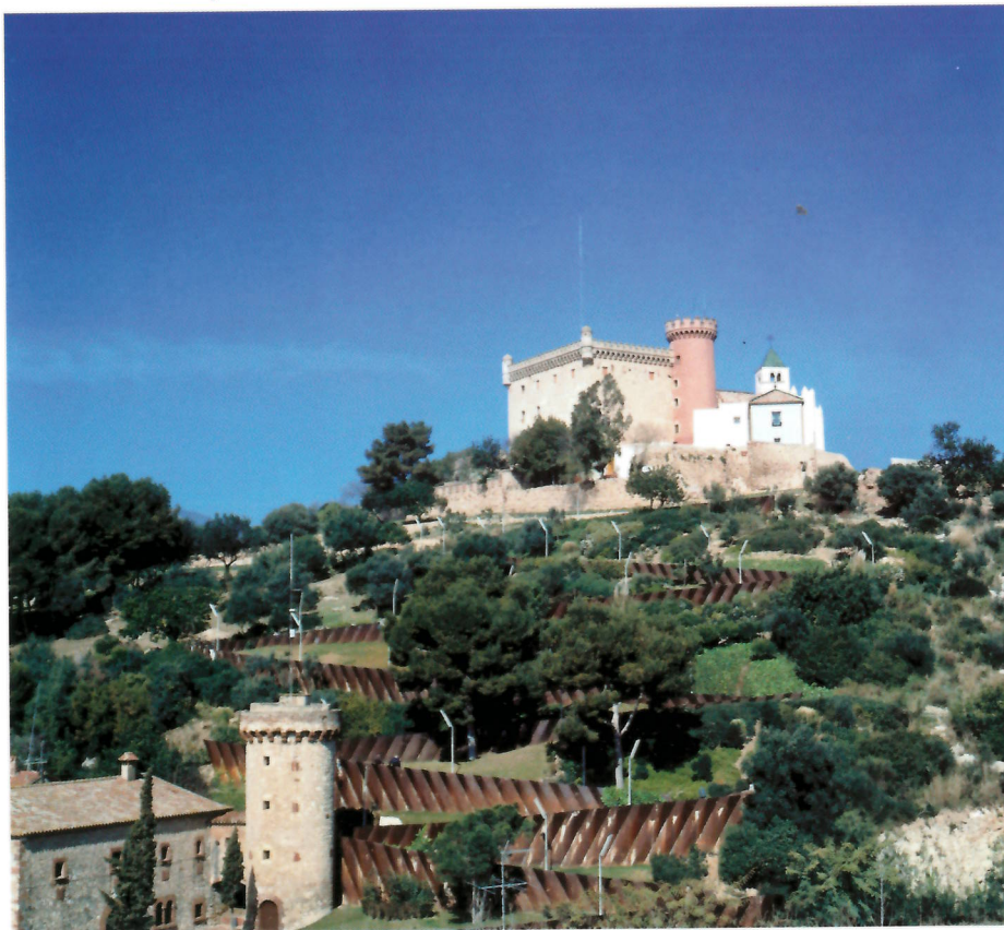
Vista del castillo y de la iglesia después de la restauración de ésta. En primer término, el nuevo parque del cerro. (Foto: Montserrat Baldomà, 12 de marzo de 1996.)
