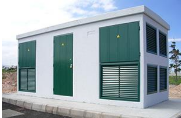
Figura 9. Imagen edificio centro de transformación. Fuente: www.adhorna.es
