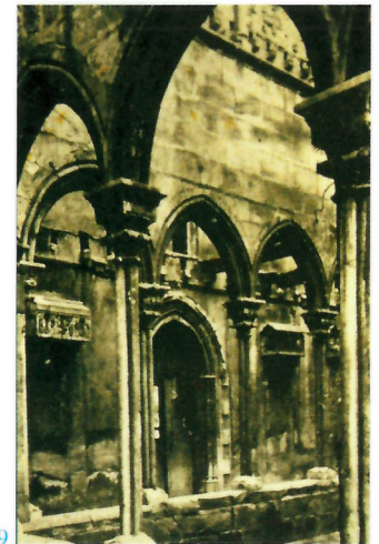
9. Barcelona. Claustro del convento de la Concepción, trasladado en 1888
