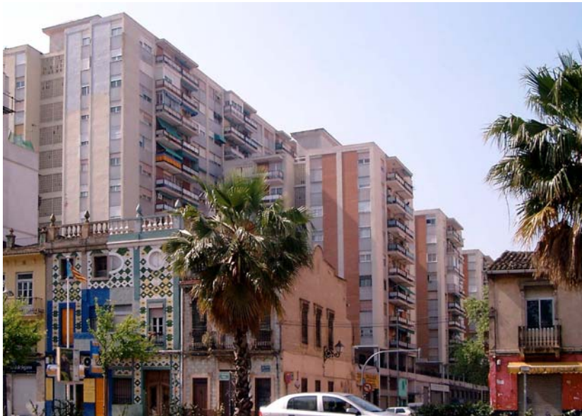
Vista actual desde la Avenida del Puerto.
