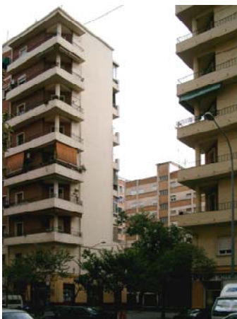
Bloques en la calle Amistat. Vista hacia el este.
