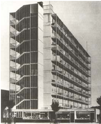
Edificio Bergpolder (Rotterdam, 1933-34), W. Van Tijen, J.A. Brinkmann y L.C. Van der Vlugt.
