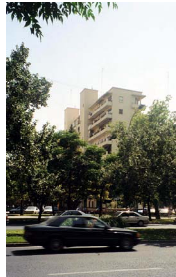
Bloque en la calle Amistat. Vista desde el Paseo al Mar.
