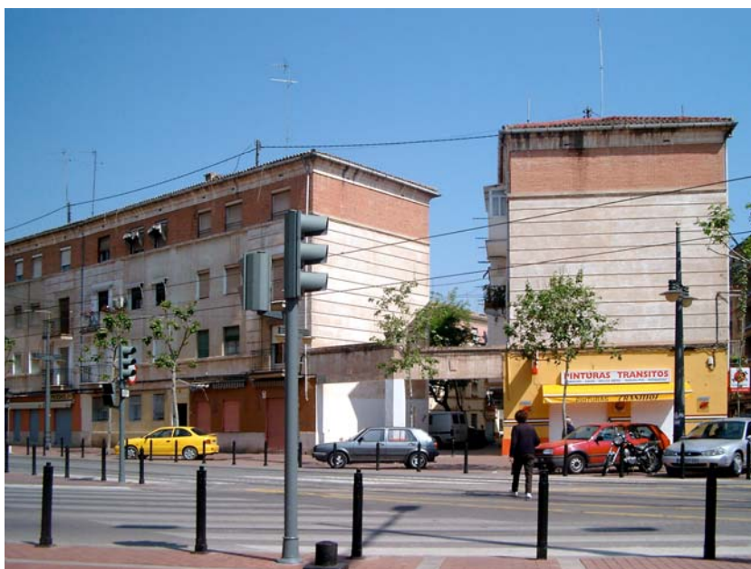
Grupo Montduver. Vista de la esquina de las calles Montduver y Loriguilla.
