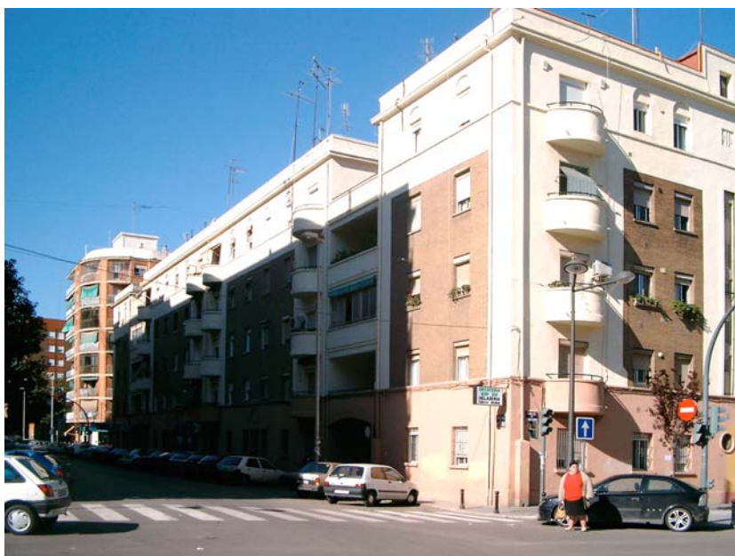
Grupo Federico Mayo. Vista actual desde la calle Maestro Valls.
