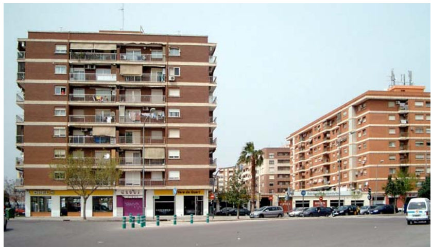
Bloques en el inicio de la calle Archiduque Carlos, lado norte
