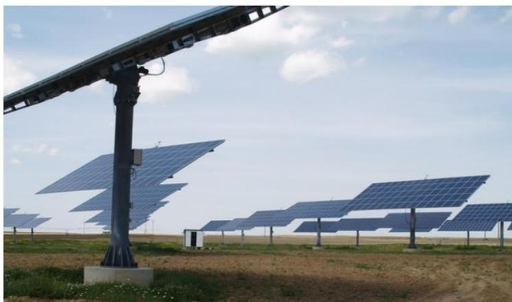
Figura 7. Seguidor de dos ejes. Fuente: <http://www.solener.info>
