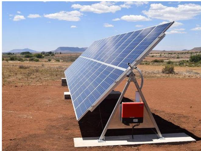
Figura 5. Seguidor de eje horizontal. Fuente: degeriberica.com
