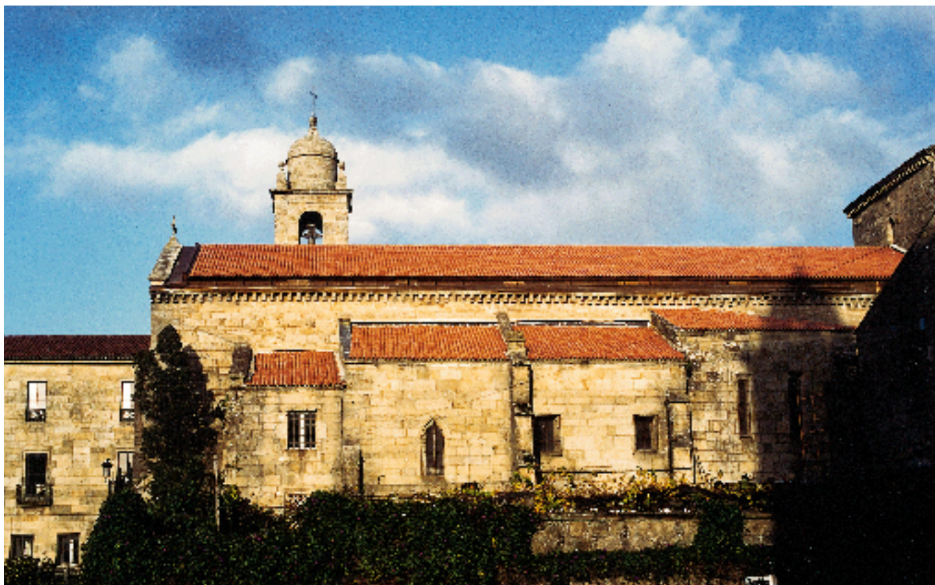
La Iglesia de San Francisco con la cubierta rehabilitada
