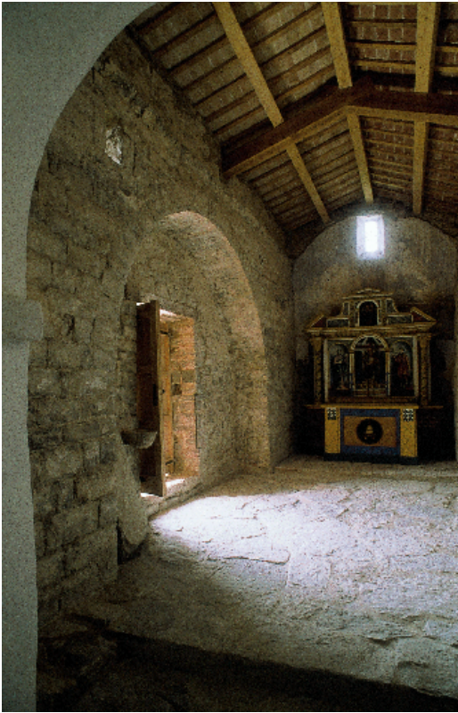
23. Interior de la iglesia, hacia poniente, después de la restauración
