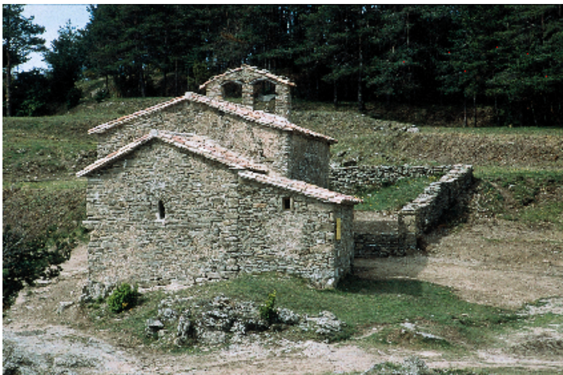
Vista de la iglesia de Sant Pere de Serrallonga, después de la restauración. (Foto: Montserrat Baldomà, 21 abril 1999)
