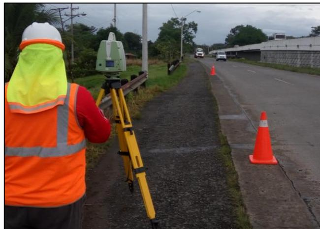
La presencia de camiones pesados generaba una serie de vibraciones tales que se tuvo que tomar la decisión de cortar el tráfico durante unos minutos. A pesar de que se trataba de una situación inesperada, el auxiliar de topografía indicó a los vehículos que circulaban en sentido a Bugaba ,que esperasen a cruzar el puente.
