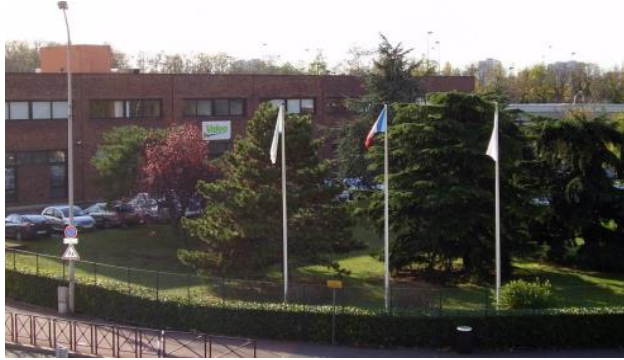
Figura 1: Centro de Valeo Creteil
