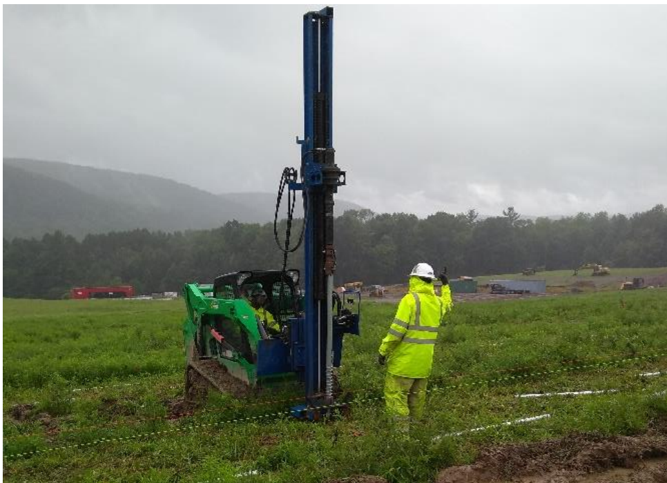
Figura 19. Imagen de una hincadora de estructuras FV
