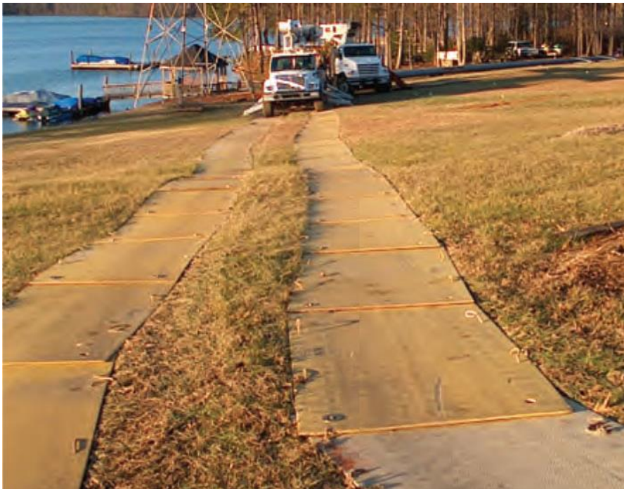
Figura 26. Ejemplo de esteras temporales de protección para los caminos de acceso [28]
