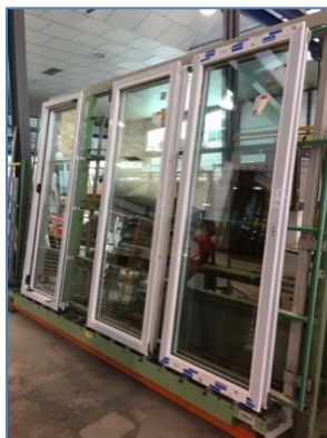
Figura 32 Operación de acristalado de ventanas (Fuente: Elaboración propia)
