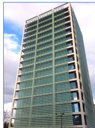
Figura 8 Fachada ventilada del complejo 9 de octubre en Valencia (Fuente: www.perfil10.es )
