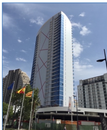
Figura 7 Muro cortina del hotel Suitopía en Calpe (Fuente: www.perfil10.es )
