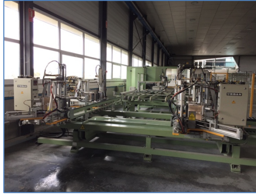
Figura 25 Operación de soldadura (Fuente: Elaboración propia)
