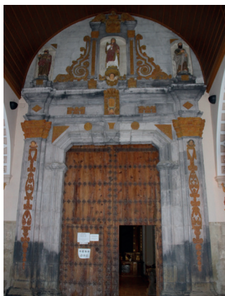
Figura 6. Entrada/pórtico de la iglesia.
