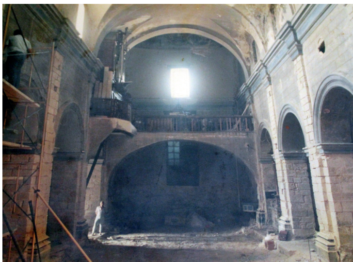
Figura 14. Fotografía de la restauración donde se descubrió la cimentación.
