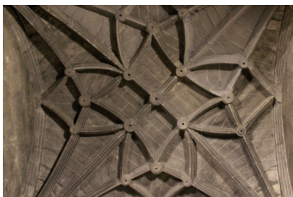
Figura 11. Bóveda de la capilla gótica.
