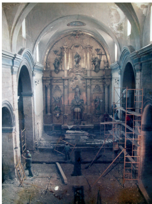
Figura 13. Fotografía de la restauración donde se levantó el pavimento.
