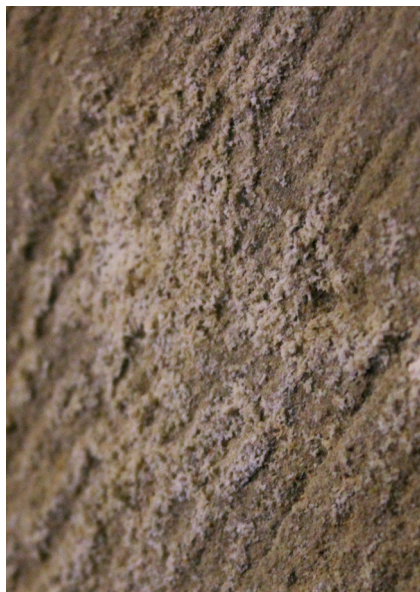
Figura 46. Detalle de las sales sobre el soporte.
