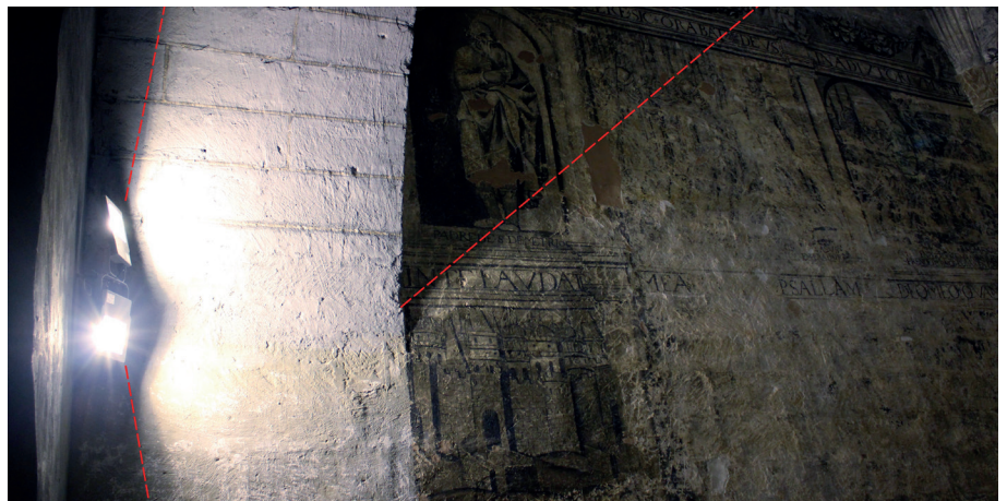
Gráfico 13. Incorrecta iluminación en la parte oeste.
