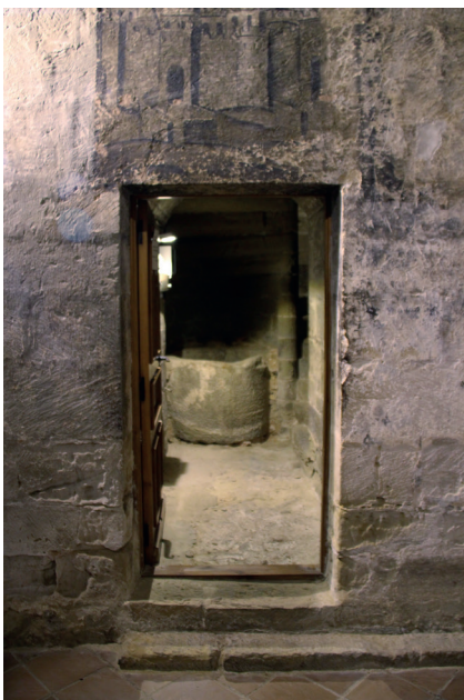
Figura 12. Puerta de acceso desde la capilla gótica al campanario.
