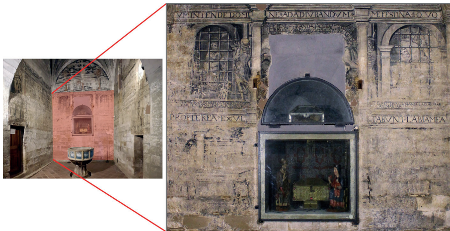
Gráfico 6. Ubicación y vista del muro norte.
