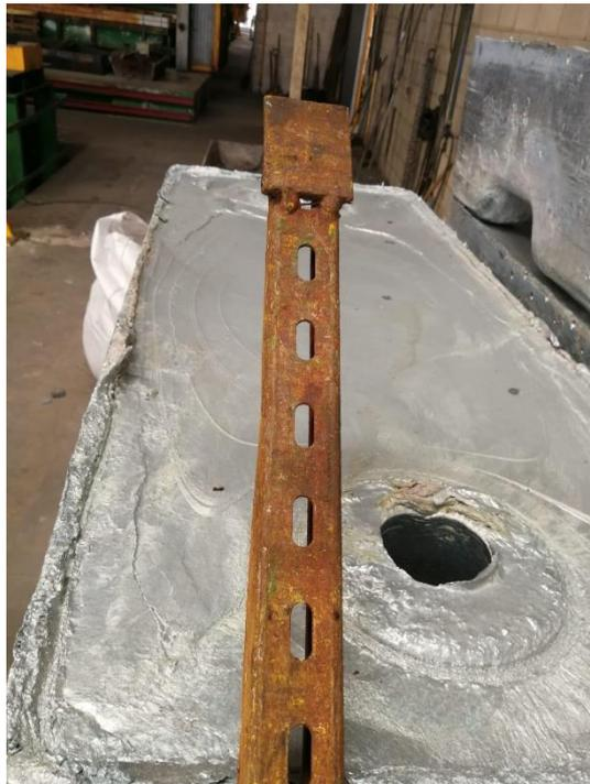
**Figura 1.4.1. Pieza de metal oxidado antes de ser tratado y galvanizado.**
