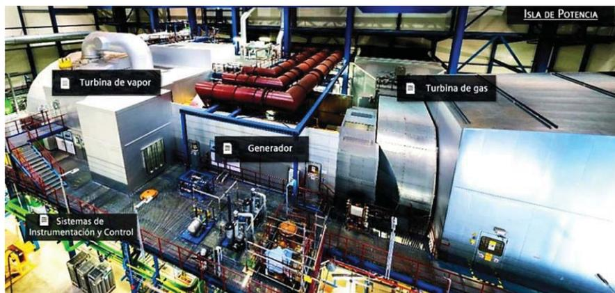
Ilustración nº 12. SGT5-4000F incluye auxiliares para turbina de vapor y generador, embrague para enlazar la turbina de vapor con el generador, equipo de control y eléctrico, etc. (Fuente: Siemens).
