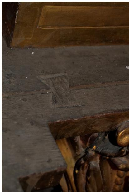
Fig. 32. Unión de dos tablas mediante una cola de milano a contraveta.
