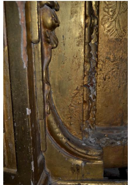
*Fig. 67-68. Empleo de adhesivos de manera inadecuada y repintes.*
