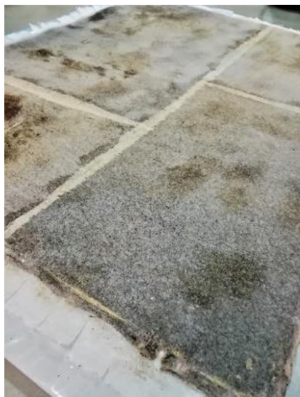
Fig.45. Protección general de la pintura
