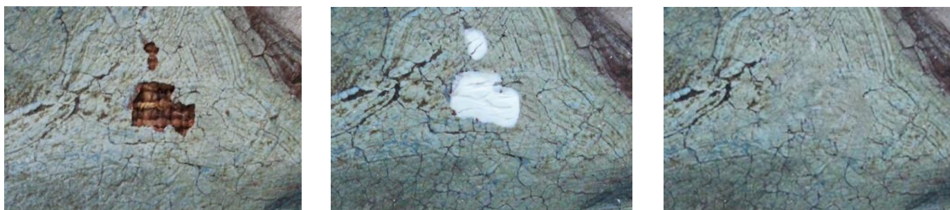
Figs.68, 69 y 70. Proceso de intervención sobre la laguna. Apariencia previa a su restauración; durante la fase de estucado y texturización; y ya finalizada.
