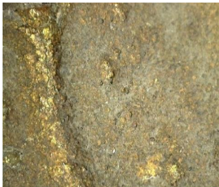
Fig.41. Detalle de acumulación de suciedad en la moldura del marco.
