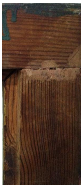
Imagen 45. Intervención de reconstrucción de soporte con masilla.
