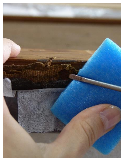
Imagen 54. Refuerzo de la protección-consolidación sobre las zonas de estratos más frágiles.
