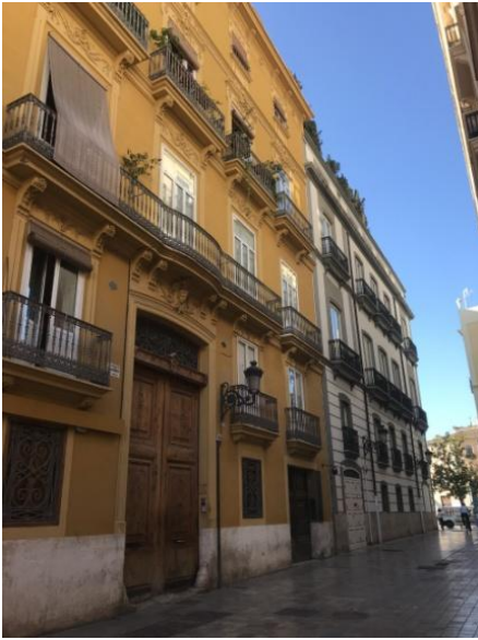
Figura 16. Fachada del edificio en donde se encuentra la obra objeto de estudio. Valencia.
