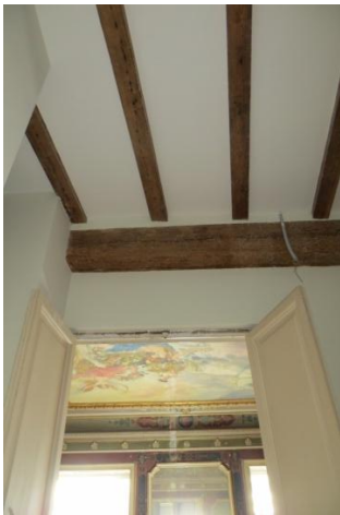
Figura 20. Vigas de madera de la sala contigua al salón donde se encuentra la pieza e estudio.
