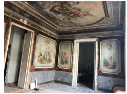
Figura 18. Interior de la sala, donde se aprecian el resto de marouflage que acompañan a la obra. (zona sur).
