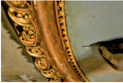
Figura 46. Catas de limpieza acuosa con solución madre, tensoactivo débil y quelante débil a pH7.
